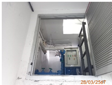
Booster Pump ชั้นดาดฟ้า
